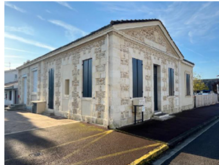
Façade école M. Rebeyrol après travaux
