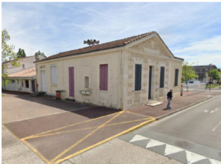
Façade école M. Rebeyrol avant travaux
