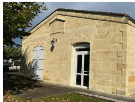
Façade Espace Mosaïque après travaux
