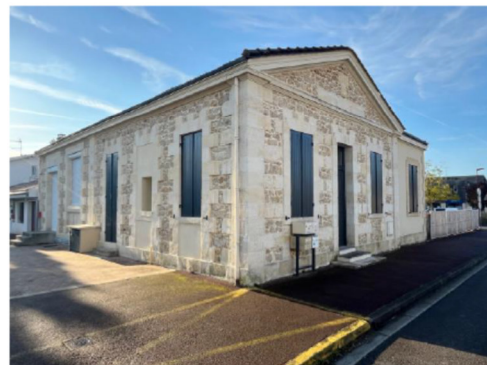
Façade école M. Rebeyrol après travaux
