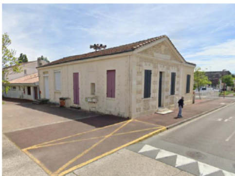
Façade école M. Rebeyrol avant travaux
