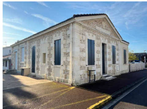
Façade école M. Rebeyrol après travaux
