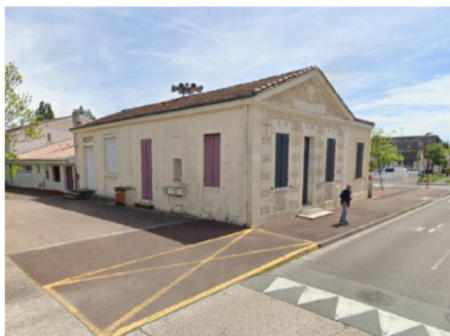
Façade école M. Rebeyrol avant travaux
