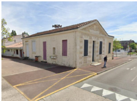
Façade école M. Rebeyrol avant travaux
