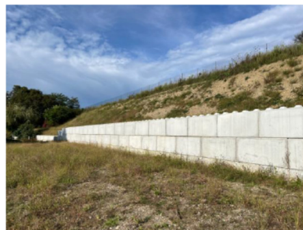
Butte anti-bruit après travaux et création d'un mur de soutènement
