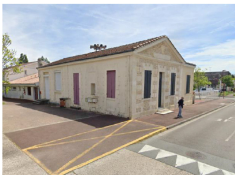
Façade école M. Rebeyrol avant travaux
