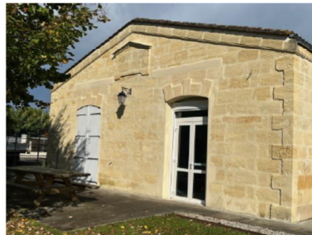
Façade Espace Mosaïque après travaux
