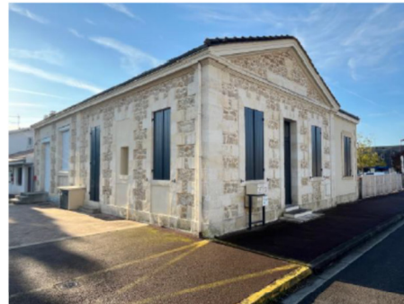
Façade école M. Rebeyrol après travaux
