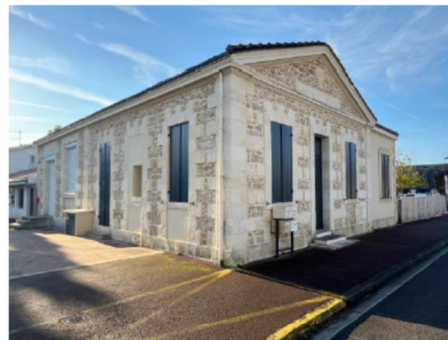
Façade école M. Rebeyrol après travaux
